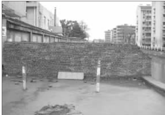
坍塌路口处被封住(图一)
