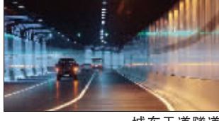
城东干道隧道
