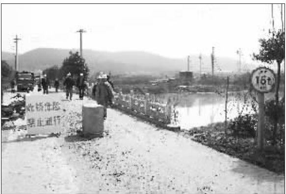
桥上立起禁行牌实属无奈
