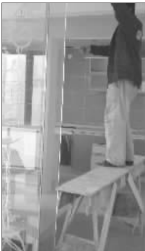
油漆工正在认真施工
