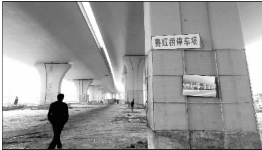
赛虹桥立交桥下的花坛成了一片工地 快报记者 赵杰 摄
