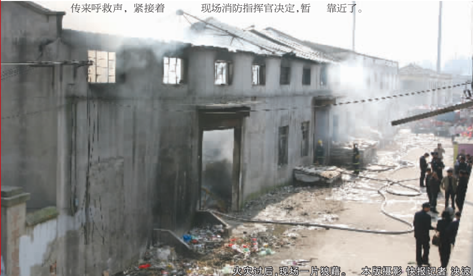
火灾过后，现场一片狼藉。 本版摄影 快报记者 洪波
