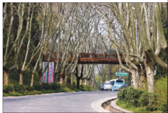
一座天桥兀然横卧,跨越陵园路
