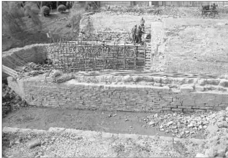
挖开路面露出真容的赛虹桥
