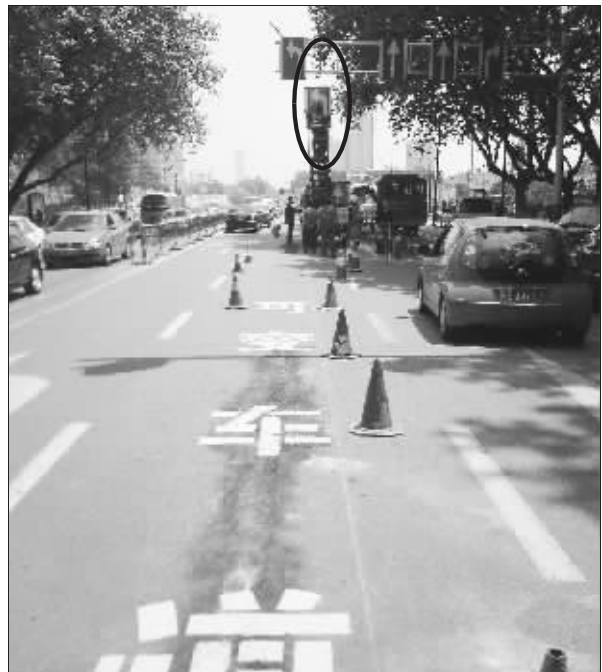
工人正在架设可变车道指示牌 通讯员 郭蓉 摄
