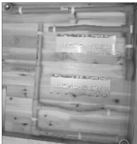
水管铺设工艺
