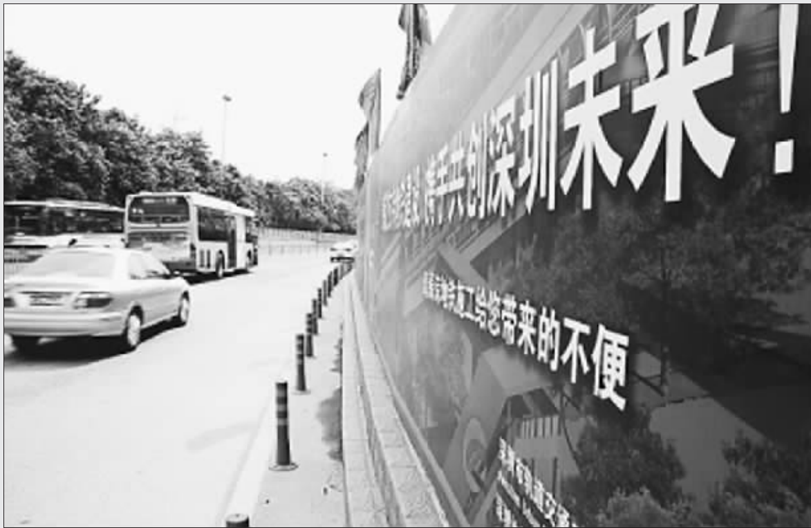
深圳街头地铁修建工地,向市民道歉的公示牌
