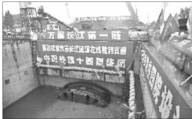
昨天,盾构机在江心洲工地穿出隧道口,这标志着长江隧道左线贯通 快报记者 洪波 摄
