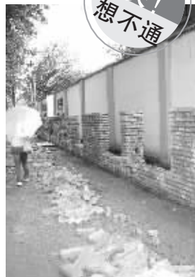
在建的墙据称是景观墙
