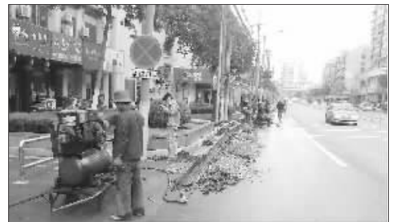
学前街移动综合线路铺设现场
