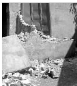
厕所的外墙已被敲掉
