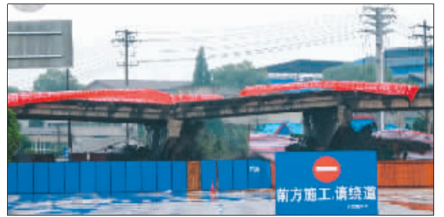
27日,湖南株洲红旗路事故高架桥开始爆破 新华社记者 明星 摄
