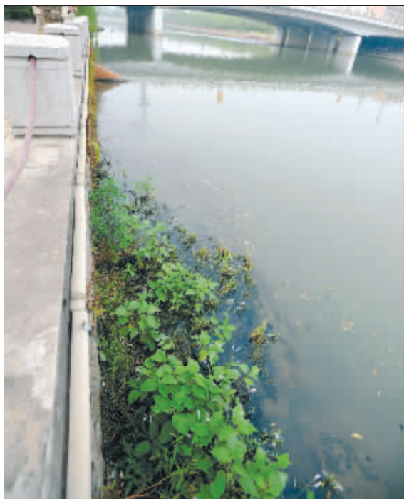
水中花园不见了，不远处赫然是根排污管
