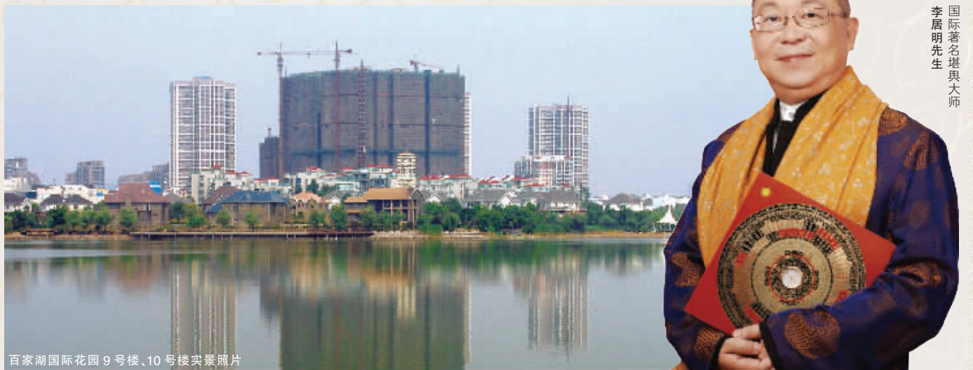
百家湖国际花园9号楼、10号楼实景照片
