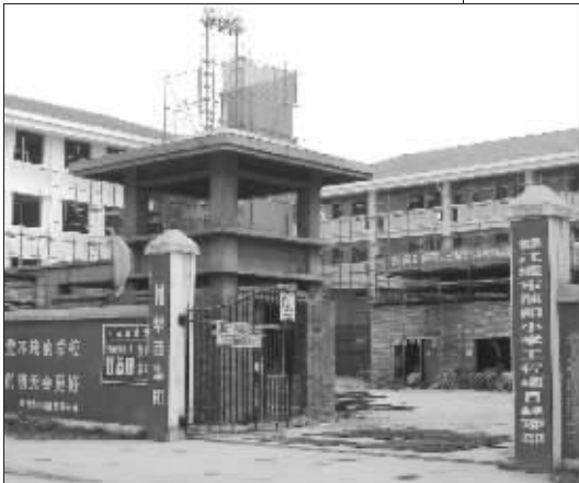
正在建设中的蒲阳小学
