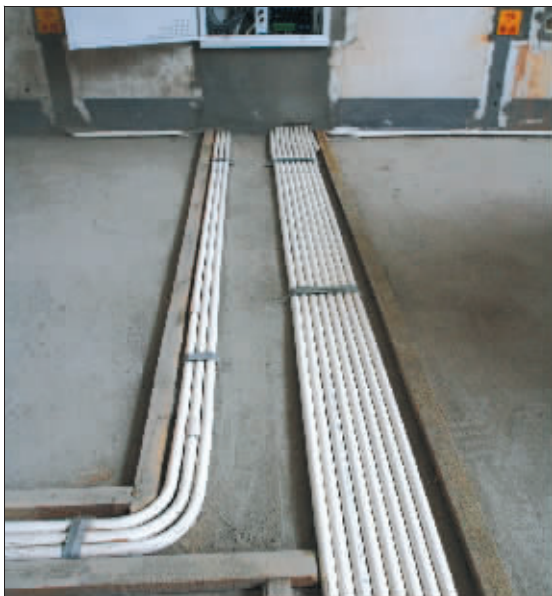
十年质保的关键还在施工质量。看了这样的施工现场,还有什么不放心的? 快报记者 路军 摄
