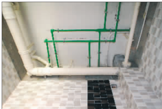
水路从顶上走,既方便施工也利于将来维修
