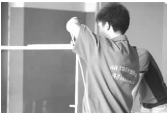
木制品的基层框架尺寸要划分准确,保持水平垂直,平整光滑
