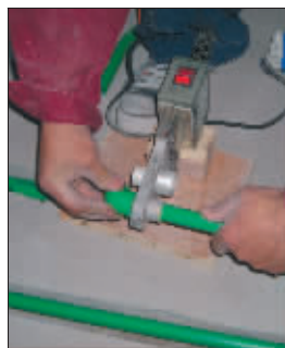
锦华的工人在一丝不苟地施工
