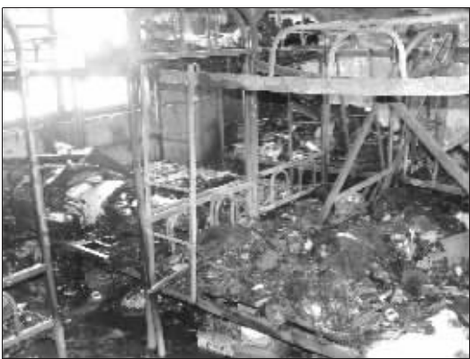
摆满床位的房间被烧得一塌糊涂 快报记者 孙玉春 摄
