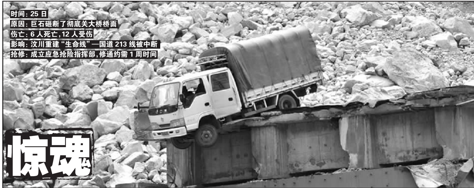
大桥断裂处悬挂着一辆货车
