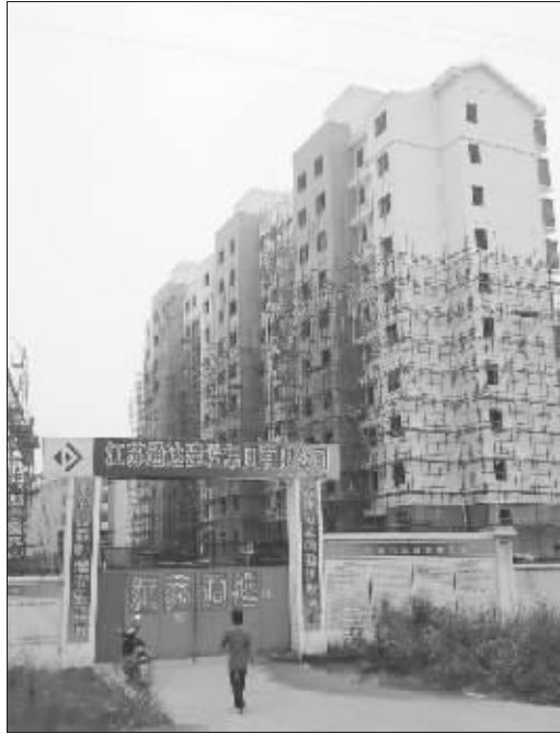
小区工地大门紧闭
