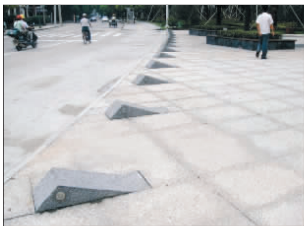
这些机动车障碍设施隐患重重
