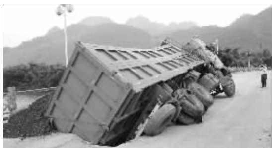
公路桥路面被超载运煤车压塌 新华社发(曹青摄)
