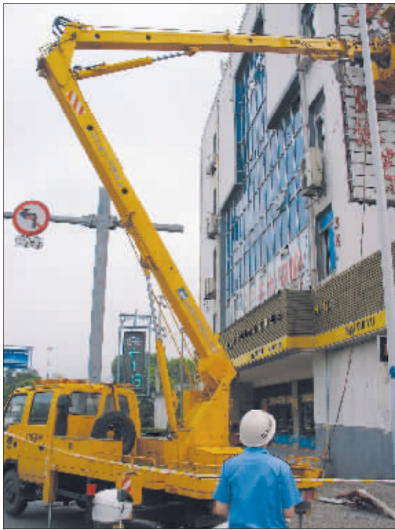
苏州城管为防台风,提前上街拆除危险广告牌。 王彪摄
