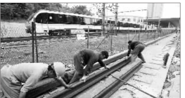
一号线南延线钢轨铺进安德门车站 快报记者 顾炜 摄
