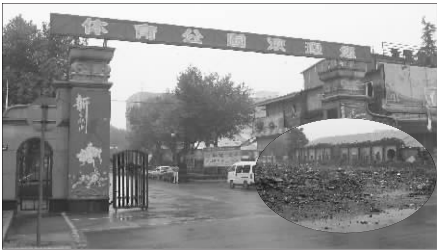
无锡体育公园的一些老建筑正在拆除(小图),要不了多久,这个大门也会被更漂亮的建筑取代
