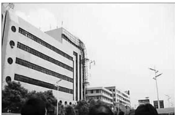
楼顶十几米高的铁塔轰然倒塌
