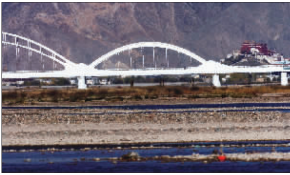
青藏铁路拉萨河特大桥与布达拉宫遥遥相望(2005年10月10日摄)。
