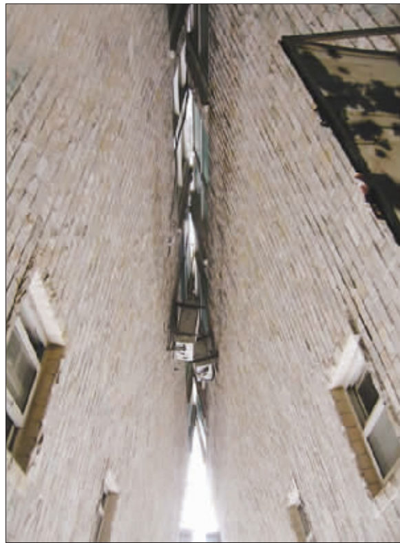
成都斜楼现场
