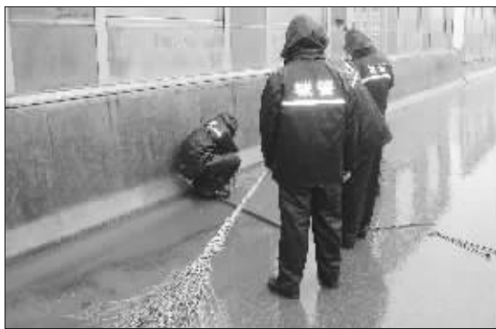
城管队员冒雨疏通凤翔高架上的下水管道 唐奕 摄
