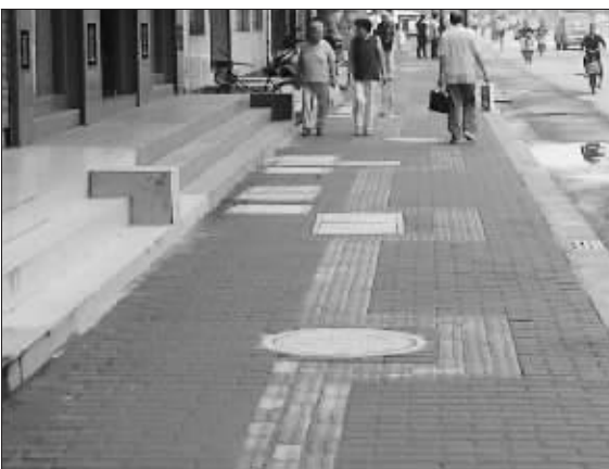
为了避开窨井,这条盲道转了8个弯 薛晨 摄
