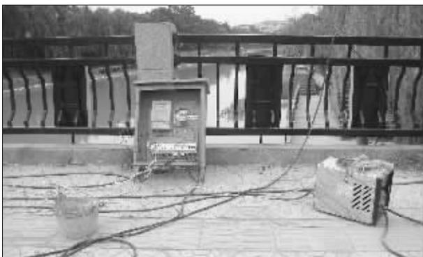
9月8日下午5点左右，读者张先生经过红梅公园附近的丹青桥时，看到桥上一只没有柜门的临时电柜上正插着一台电焊机，里面的插座全部裸露在外，现场也没专人看管。他认为这样用电很不安全，很容易发生触电事故。
