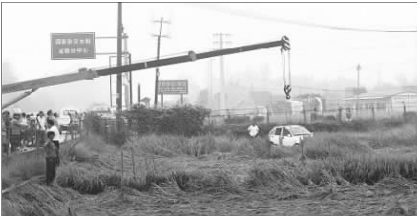
吊车吊起闯祸奥拓
