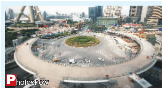
近日,上海最大的人行天桥——陆家嘴“C”形明珠环人行天桥主体工程基本完工。天桥中心直径约117.5米,将于世博会召开前正式投入使用。 ■新华社发
