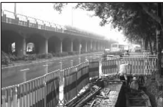
城西干道路旁正在围挡施工 快报记者 泱波 摄
