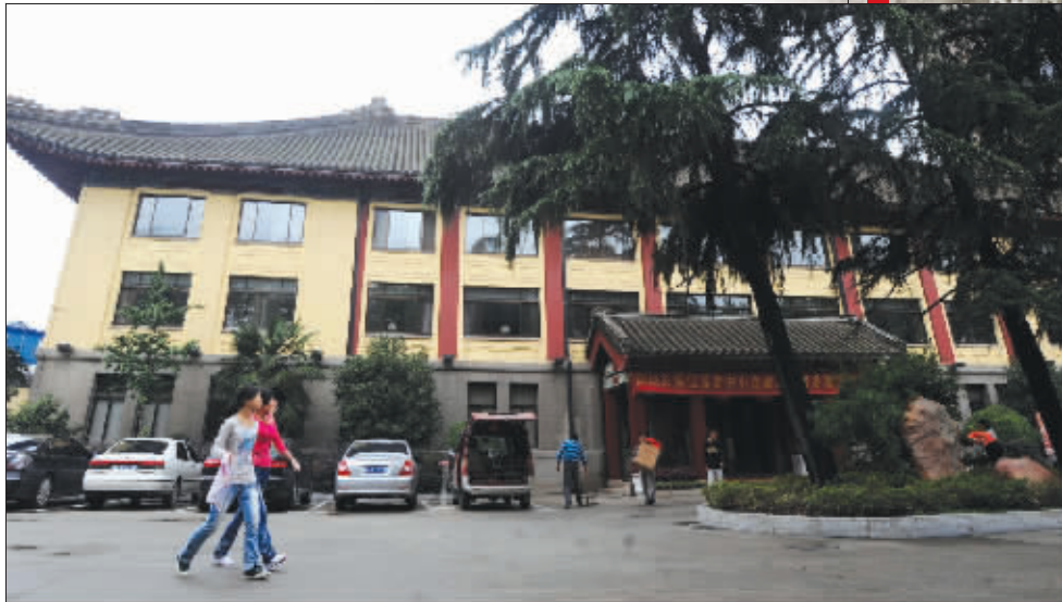
虎殿顶式的屋顶上和飞檐翘角里散发着浓浓的民国风情
