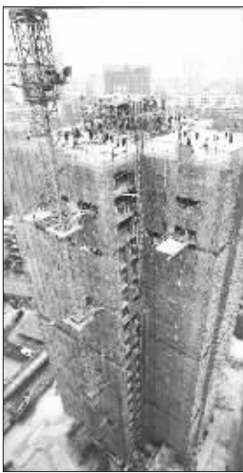
大楼建到20层才拆
