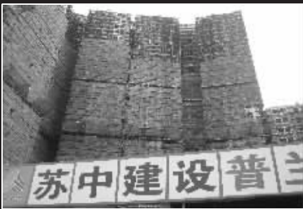
事发后工地仍在正常施工
