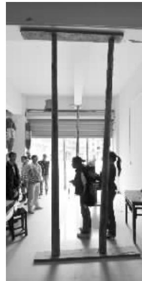
十分低劣,未按设计要求施工。底楼大梁已断裂。”
