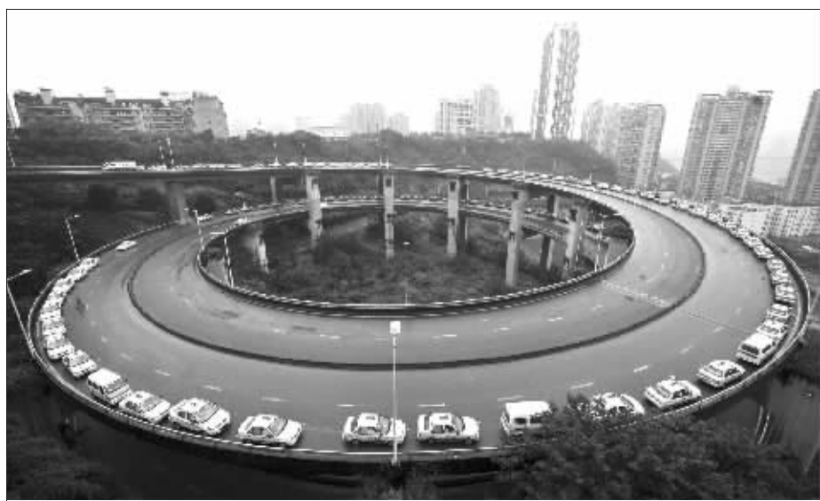
11月18日,由于天然气供应紧张,重庆新田湾加气站外等待加气的车辆在环形桥上排起了长队 IC图
