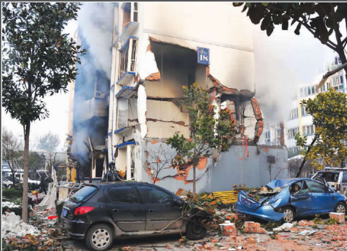
昨天凌晨,河南濮阳市一幢6层居民楼因燃气泄漏发生爆炸,造成楼房2、3层部分坍塌,9人受伤、5人遇难。 新华社发
