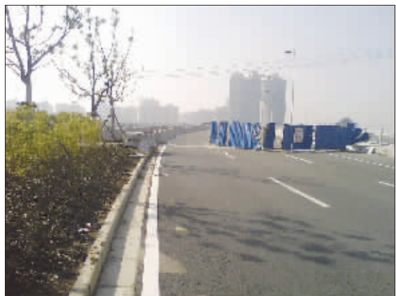
红星桥北幅桥面已经基本完工 薛晨 摄
