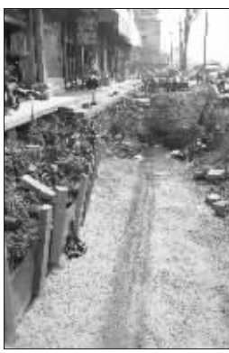
在居民楼房前开挖的大坑
