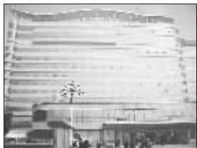
大名县人民医院大楼
