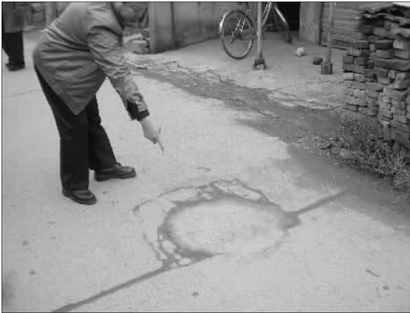
事故发生后,窨井盖已用水泥填平
