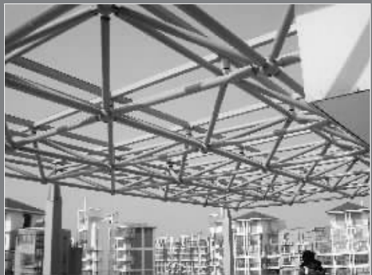
已建好的球形钢架结构阳光房顶蓬
